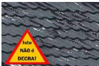
Usar uma resina acrílica de baixo custo para anexar grãos de pedra à telha de aço pode resultar em altas perdas durante o fabrico, transporte, instalação e durante a chuva. O aço fica também exposto ao aparecimento de ferrugem.
