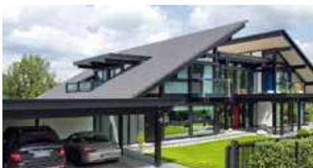
Um telhado de uma água em betão requer construtores muito experientes, assim como uma mistura exacta dos aditivos de impermeabilização no betão. Em caso de erro levará a enormes problemas futuros. A membrana pode fissurar e permitir infiltrações
