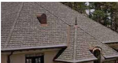
As telhas ou telas de asfalto/ betume são geralmente feitas de papel usado, revestido com betume, asfalto e grânulos cerâmicos. Por isso ficam suscetíveis aos danos causados pelo fogo e chuvas fortes. Cada tela necessita fixação individual, que eleva bastante o custo de instalação desta solução
