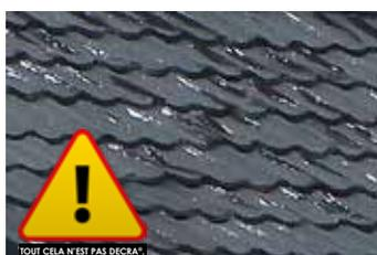
L'utilisation d'une couche de base bon marché pour fixer les éclats de pierre sur la couche d'acier peut entraîner de lourdes pertes d'éclats pendant la fabrication, le transport, l'installation et en cas de pluie. Cela expose l'acier à un début de rouille
