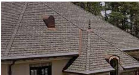
Les bardeaux de bitume ou d'asphalte sont généralement fabriqués à partir de déchets de papier, recouverts de bitume et d'asphalte, et de granulés de céramique. Le fait d'être en papier les rend vulnérables au feu et les fortes pluies provoquent des dégâts permanents. Chaque tuile doit être fixée individuellement, de sorte que les bardeaux de bitume ont tendance à être coûteux à installer.
